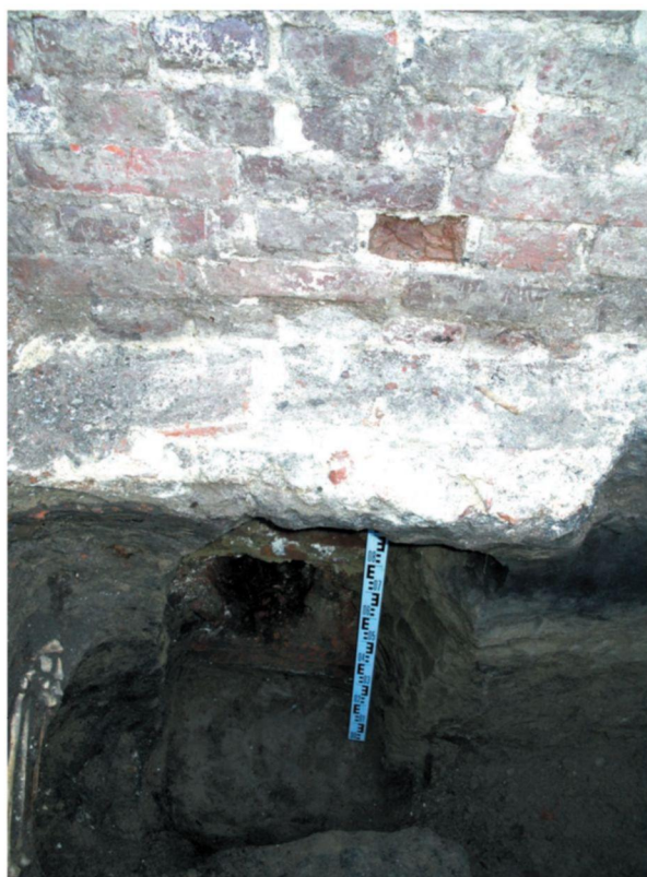
Рис. 1. Фундамент центрального придела Спасской церкви
