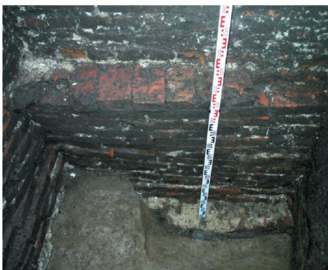
Рис. 2. Основа фундамента колокольни Спасской церкви
