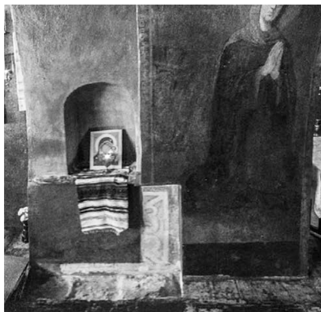
Рис. 22. Собор Чуда Михаила Архангела Выдубицкого монастыря. Цокольная панель на северном пилоне арки, ведущей из нартекса в наос.
