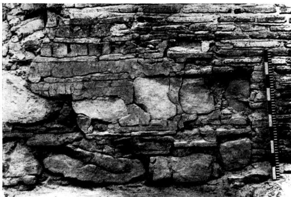
Рис. 10. Часть южной стены собора (слева — кладка XI в., справа — кладка XIII в.).
