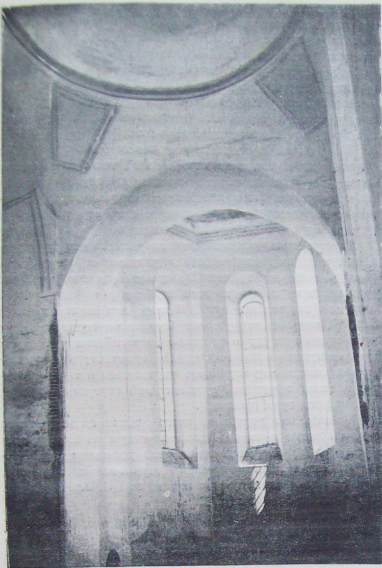
Церковь с. Лютенки. Внутренний вид
