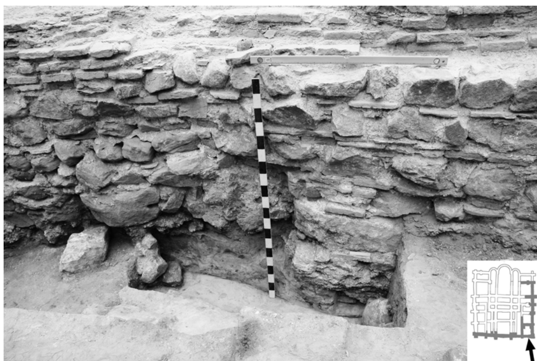
4. Фото угла с юга 2007, фото угла с запада 2006
