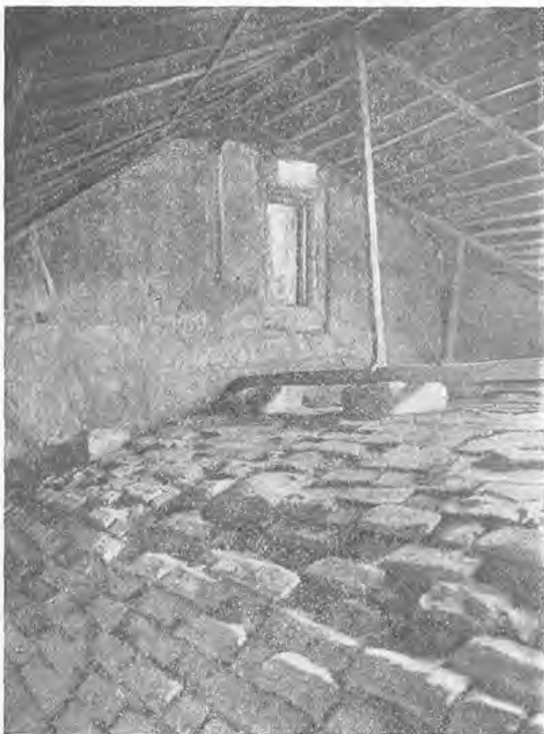
Рис. 35. Перекрытие у северо-западной главы собора. Вид с чердака.
