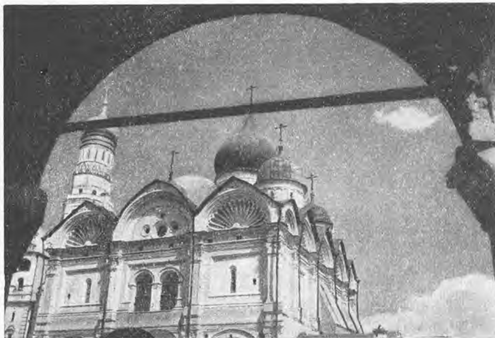
Рис. 29. Западный фасад. Фрагмент
